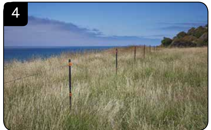
4 Plaats de tussenpalen
